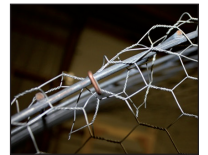
Costruzione gabbie Cage manufacture
